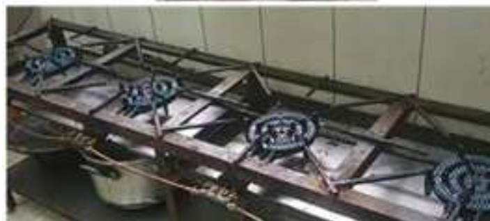
Instalación de los fogones nuevos en estufas industriales
