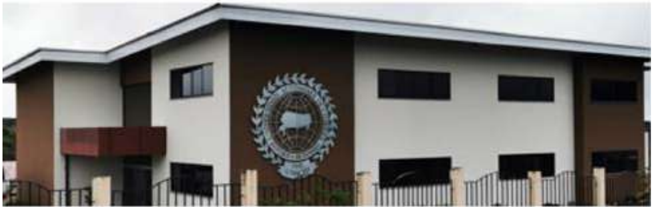
Construcción del Edificio de la Sede del Centro Regional de Boquete de la UNACHI
