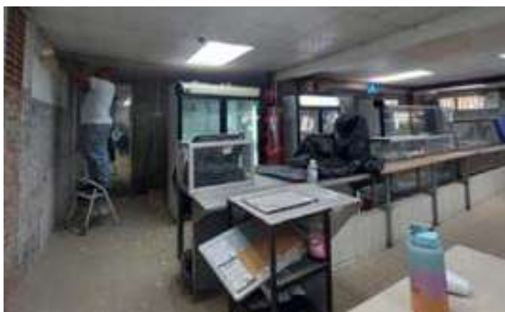
Mantenimiento y remodelación en Cafetería
