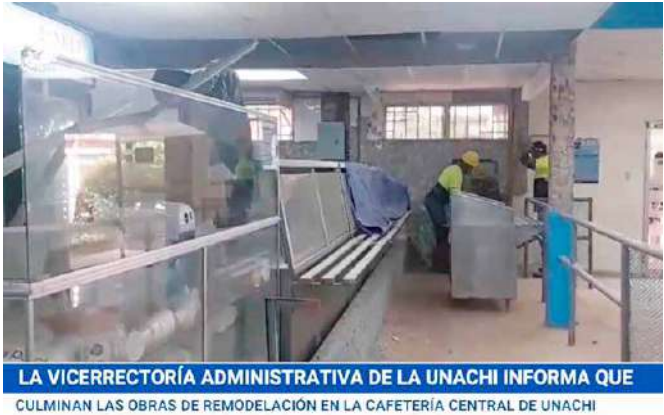
Remodelación de Cafetería Central
