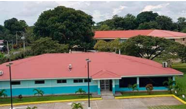
Figura 42 Laboratorio de Aguas y Servicios Fisicoquímicos (LASEF)
