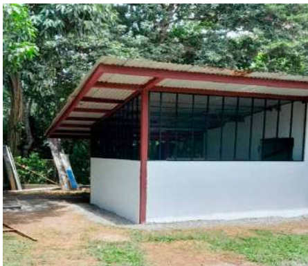
Figura 57 Remodelación de Cafetería del Centro Regional Universitario Oriente
