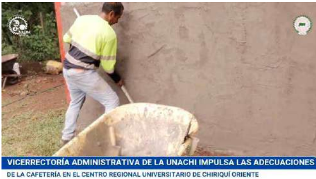
Figura 56 Remodelación de Cafetería del Centro Regional Universitario Oriente
